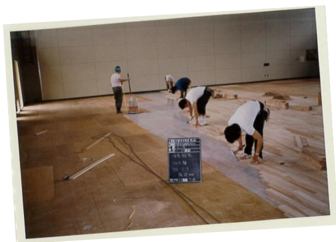
体育館を作っているところ!!
